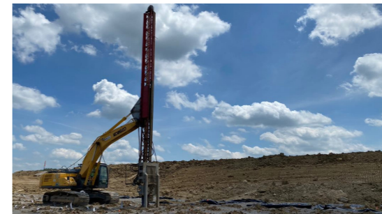
Turnstile Data Center (USA)
